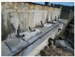
写真-60 落橋防止鋼材
