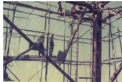
写真-9 斜材の取り換え
