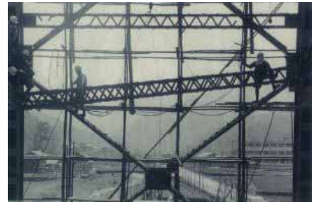
写真-8 水平材の取り換え
